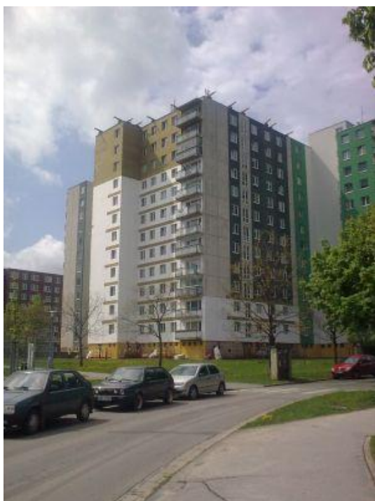
Požárně dělící pásy v ETICS dle požadavků ČSN 73 0810
